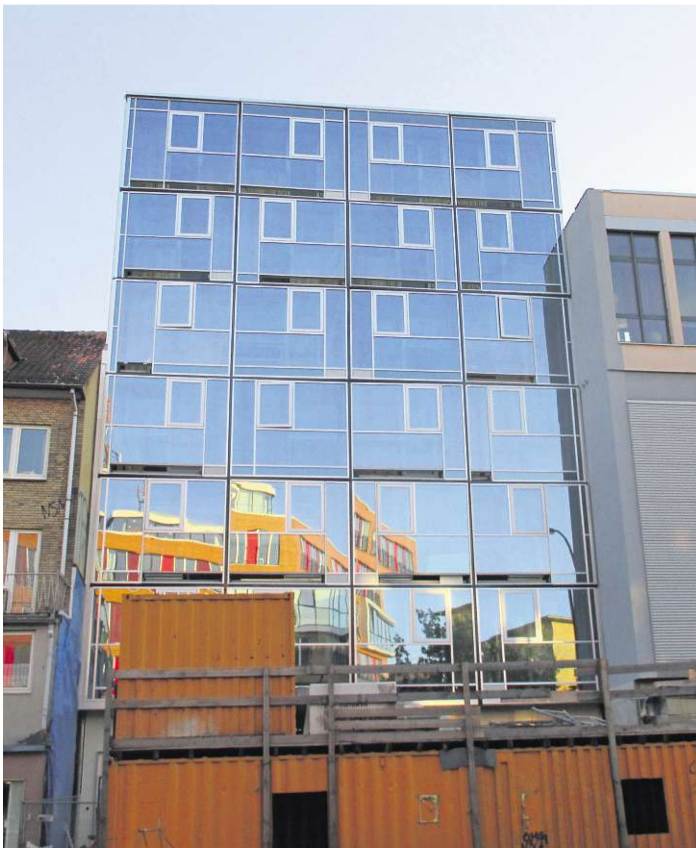
Bald wird der Neubau an der Hoheluftchaussee mit der verspiegelten Glasfassade bezogen
